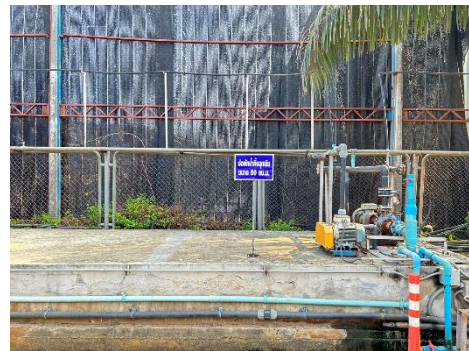
ภาพที่ 2-16 ถังพักน้ำทิ้งฉุกเฉินขนาด 50 ลูกบาศก์เมตร
