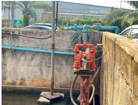
ภาพที่ 2-19 ปืนที่สูบน้ำฝนบริเวณลานถัง
