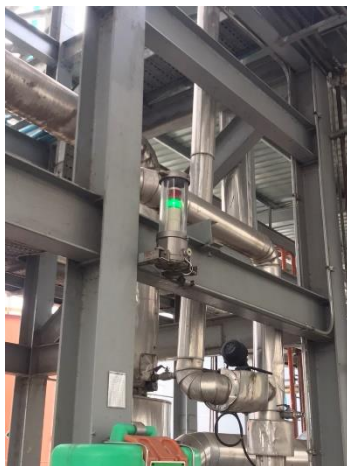
ภาพที่ 2-47 เครื่องตรวจวัดความเป็นพิษของสารเคมี (Toxic Gas Detector)
