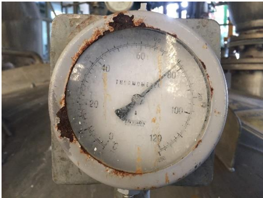
ภาพที่ 2-45 อุปกรณ์ตรวจวัดอุณหภูมิและความดันของถังปฏิกิริยา
