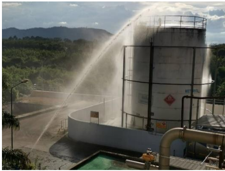
ภาพที่ 2-48 ระบบ Deluge Sprinkler และ Fire Detector ที่ถังเก็บกากเมทานอล
