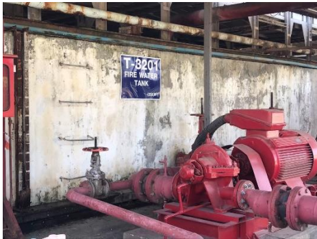
ภาพที่ 2-58 เครื่องสูบน้ำดับเพลิงและถังเก็บน้ำสำรองดับเพลิง
