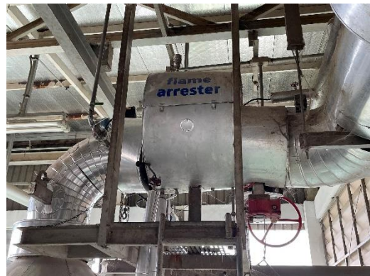
ภาพที่ 2-50 Flame arrester
