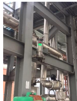
ภาพที่ 2-5 เครื่องตรวจวัดการรั่วของฟอร์มัลดีไฮด์แบบต่อเนื่อง (Gas Detector)
