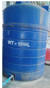
ภาพที่ 2-17 ถังพักน้ำทิ้งฉุกเฉินขนาด 10 ลูกบาศก์เมตร
