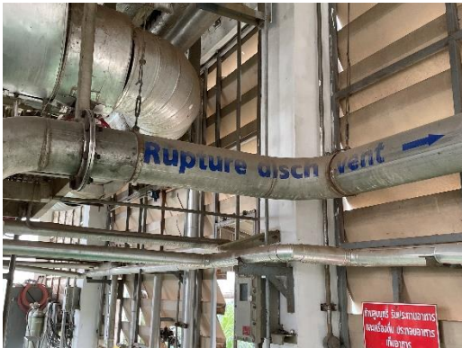
ภาพที่ 2-52 Rupture Disc
