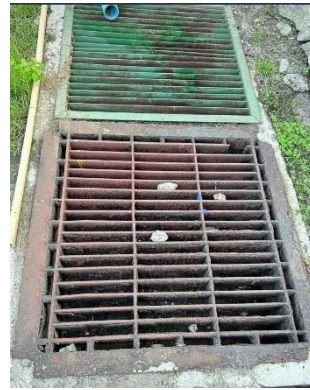
ภาพที่ 2-26 บ่อดักน้ำมันเพื่อรองรับน้ำและน้ำมันดีเซล รั่วไหล
