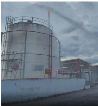
ภาพที่ 2-20 คันคอนกรีตกั้นน้ำบริเวณลานถังเก็บกักสารเคมี
