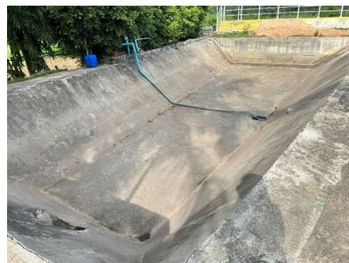
ภาพที่ 2-24 บ่อหน่วงน้ำขนาด 100 ลูกบาศก์เมตร
