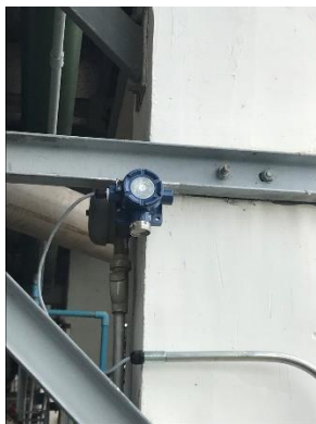
ภาพที่ 2-46 เครื่องตรวจวัดการรั่วของฟอร์มัลดีไฮด์แบบต่อเนื่อง (Gas Detector)
