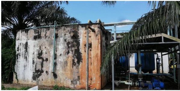
ภาพที่ 2-34 บ่อพักน้ำบาดาลขนาด 60 ลูกบาศก์เมตร
