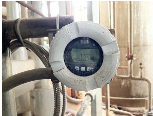
ภาพที่ 2-56 เครื่องตรวจวัดความดันที่ท่อขนส่งสารเคมี
