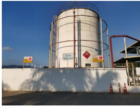
ภาพที่ 2-48 ระบบ Deluge Sprinkler และ Fire Detector ที่ถังเก็บกากเมทานอล
