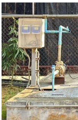
ภาพที่ 2-23 อุปกรณ์ตรวจวัดค่าความนำไฟฟ้าแบบอัตโนมัติ
