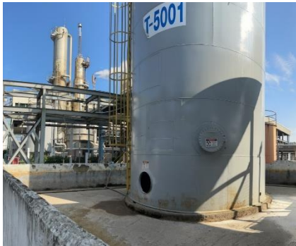
ภาพที่ 2-13 ถังพักน้ำเสียขนาด 120 ลูกบาศก์เมตร
