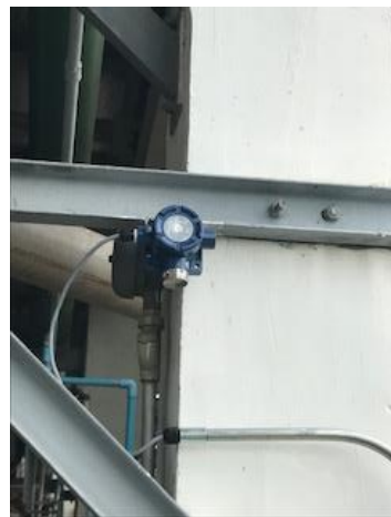
ภาพที่ 2-47 เครื่องตรวจวัดความเป็นพิษของสารเคมี (Toxic Gas Detector)
