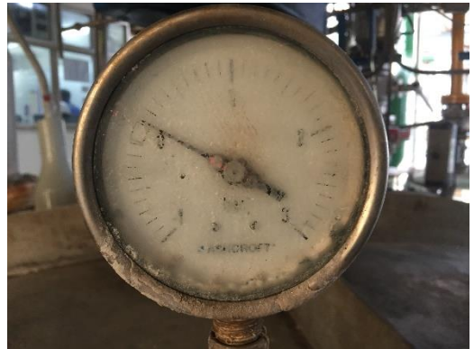
ภาพที่ 2-45 อุปกรณ์ตรวจวัดอุณหภูมิและความดันของถังปฏิกิริยา
