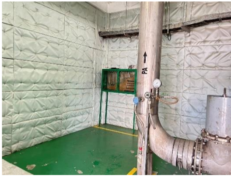
ภาพที่ 2-8 วัสดุดูดซับเสียงภายในอาคารเครื่องอัดอากาศ
