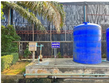
ภาพที่ 2-15 ถังพักน้ำเสียขนาด 50 ลูกบาศก์เมตร
