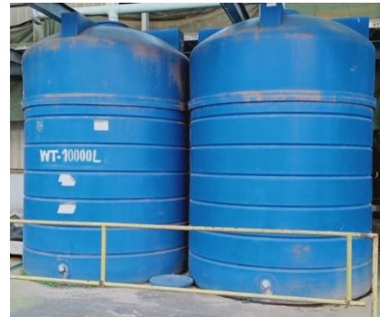
ภาพที่ 2-14 ถังพักน้ำทิ้ง 20 ลูกบาศก์เมตร
